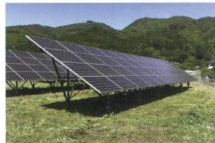
松崎発電所(大町市)
