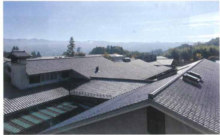
パネルを設置する「ハートヒル川路」
