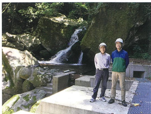
馬路村の村営発電所取水口
