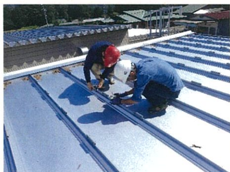
設置予定地の現地調査(工場屋根)
