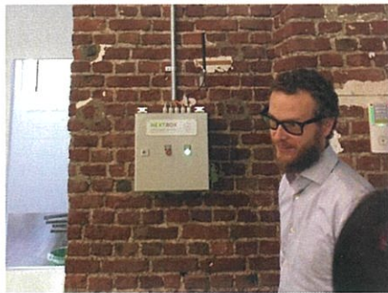
ネクストクラフトベルケ社での発電データ通信機。これで各発電所を束ねています。
